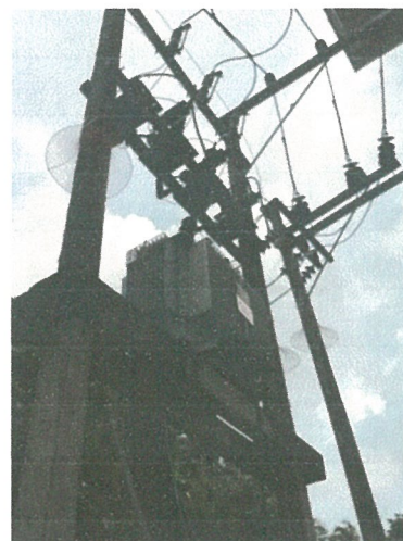
รูปภาพที่ 2.22 หม้อแปลงไฟฟ้า
